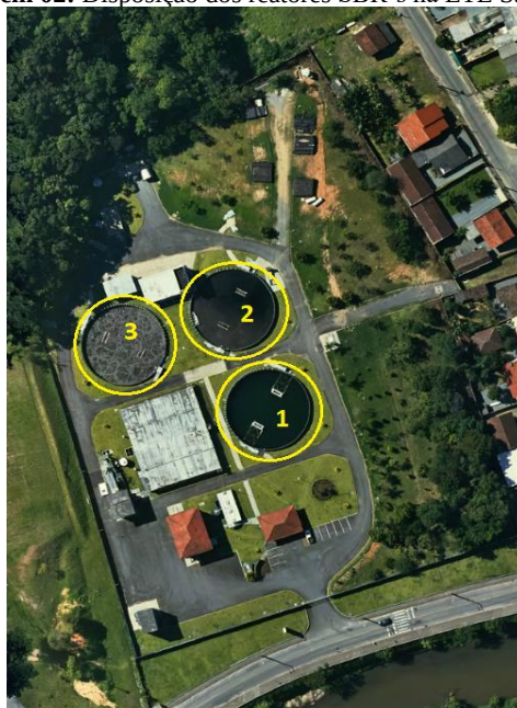
Imagem 02: Disposição dos reatores SBR's na ETE São Luis
