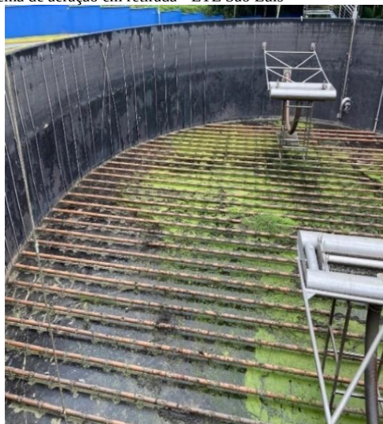
Imagem 03: Reator SBR 3 desativado e sistema de aeração em retirada - ETE São Luis
