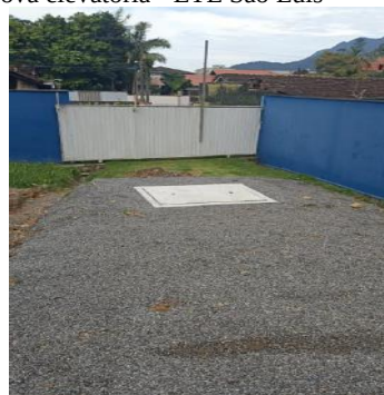
Imagem 09: PV aberto sendo transformado em uma nova elevatória - ETE São Luis
