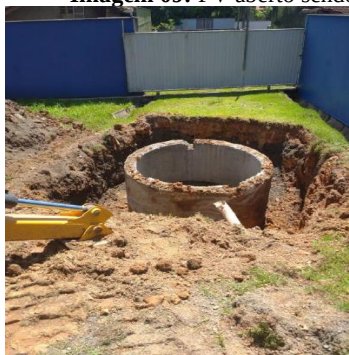
Imagem 09: PV aberto sendo transformado em uma nova elevatória - ETE São Luis
