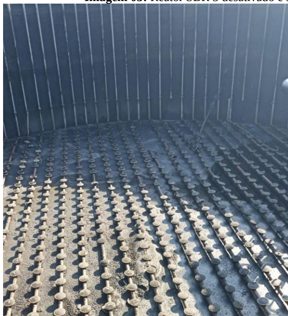
Imagem 03: Reator SBR 3 desativado e sistema de aeração em retirada - ETE São Luis
