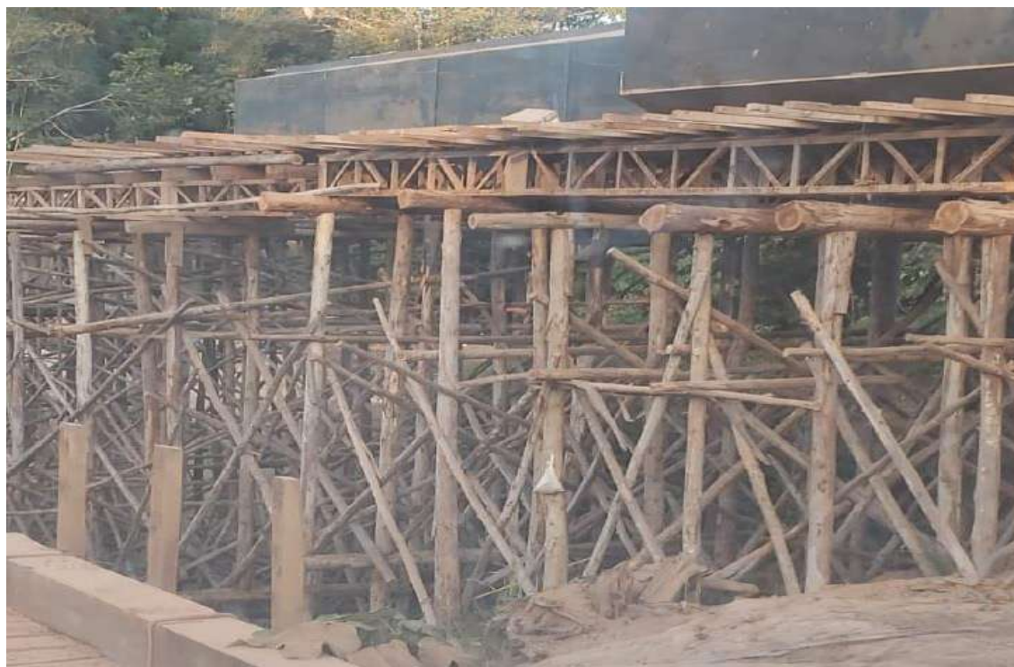
Foto 05 : Construção de Ponte Convencional de Concreto Armado Protendido(Passivo ambiental agregado)
