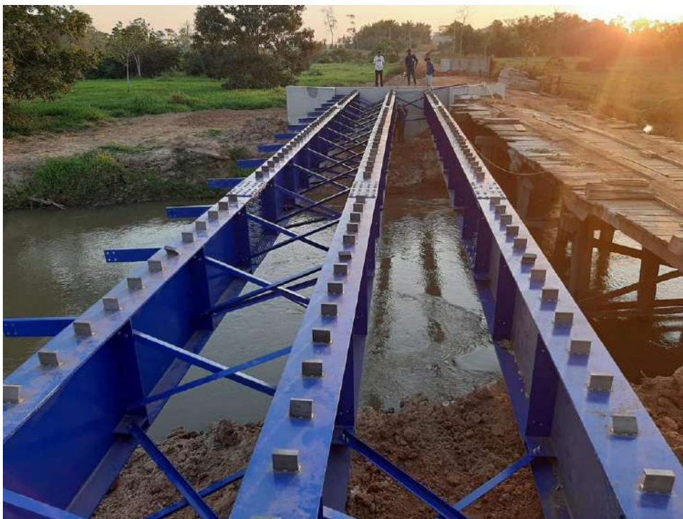
Foto 07 : Inovação Tecnológica – Superestrutura em Vigas de aço Laminado/Soldado Estrutural ASTM A36 – vãos livres até 35 metros sem apoio intermediário
