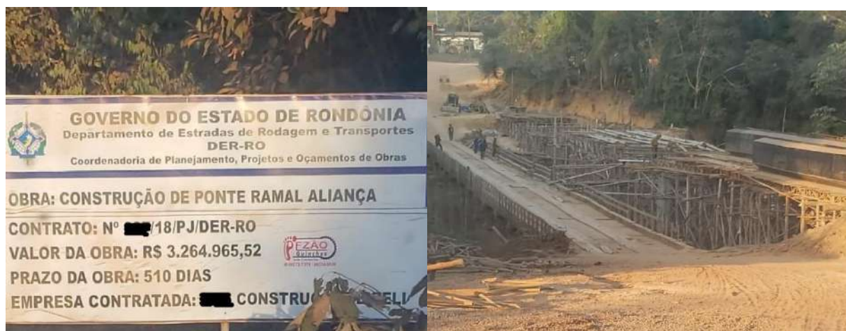
Foto 04 : Construção de Ponte Convencional de Concreto Protendido
