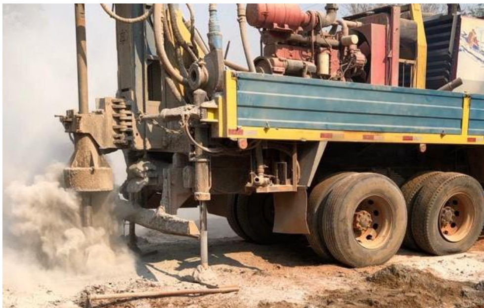
Imagens de execução da Micro-estaca-Raiz
