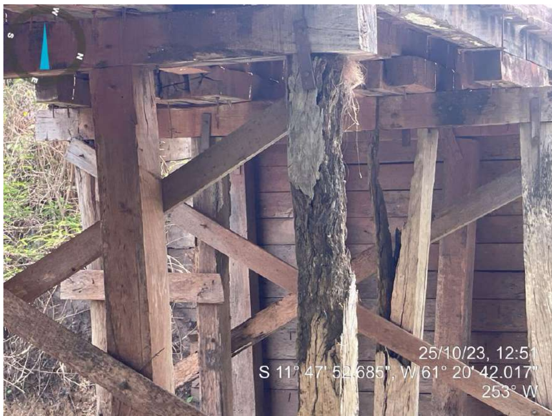
Foto 10 : Ponte existente precária a substituir – Rio Antônio João, Linha 33 Km 2,80 – Primavera de Rondônia/RO
