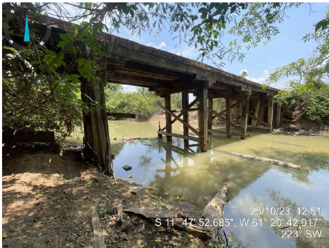
Foto 09 : Ponte existente precária a substituir – Rio Antônio João, Linha 33 Km 2,80 – Primavera de Rondônia/RO
