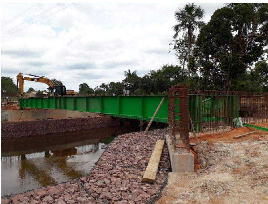
Foto 01 : Construção de Ponte Mista – Vigas em aço Laminado Estrutural ASTM A36
