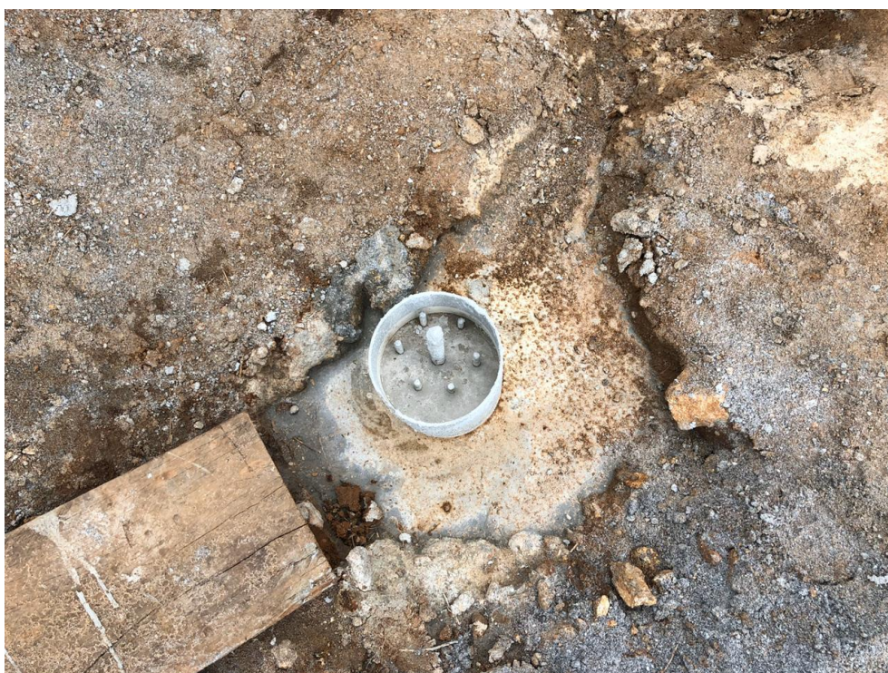
Imagens de execução da Micro-estaca-Raiz
