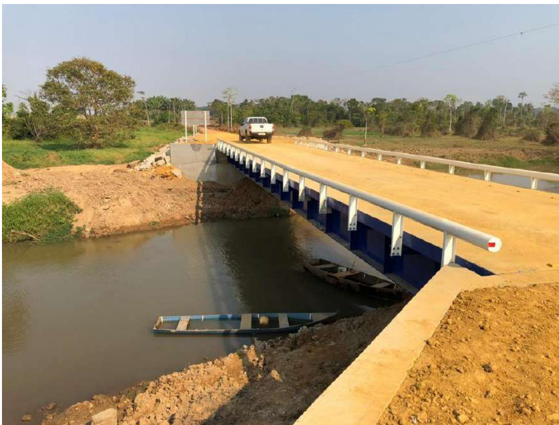
Foto 08 : Construção de Ponte Mista – executada em 46 dias – Cabixi/RO (DER) – vão livre 28m
