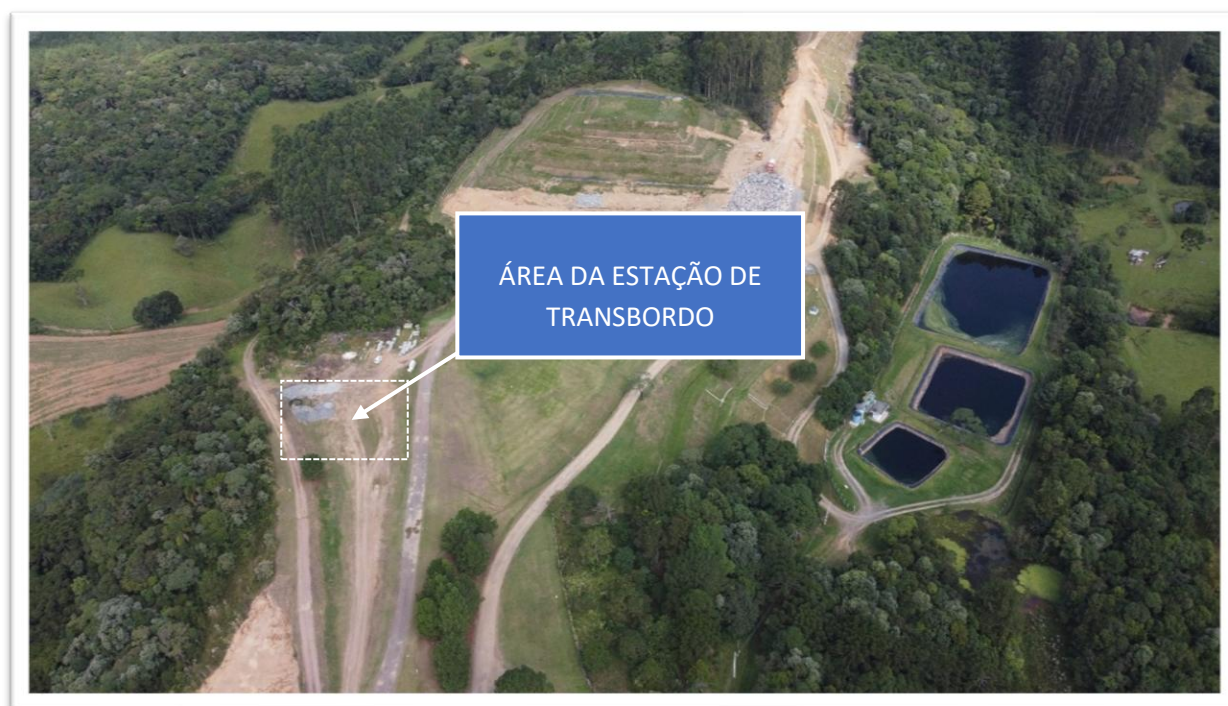
Figura 2 - Local da sondagem de solo
