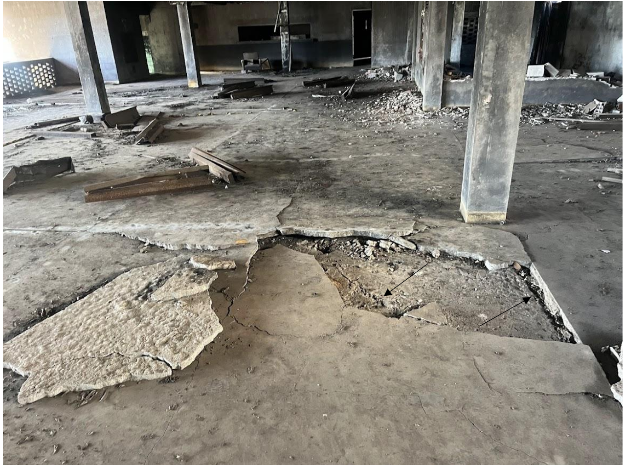
Lajes maciças do 3º pavimento para avaliação da capacidade resistente.
