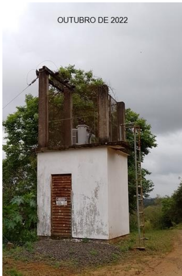
Foto 3 – Detalhe do acesso antes desta ocorrência.
