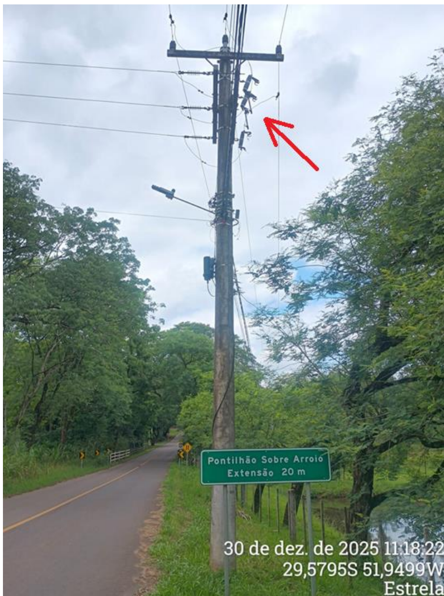
Foto 7 – Local de conexão do ramal onde houve a desenergização prévia.
