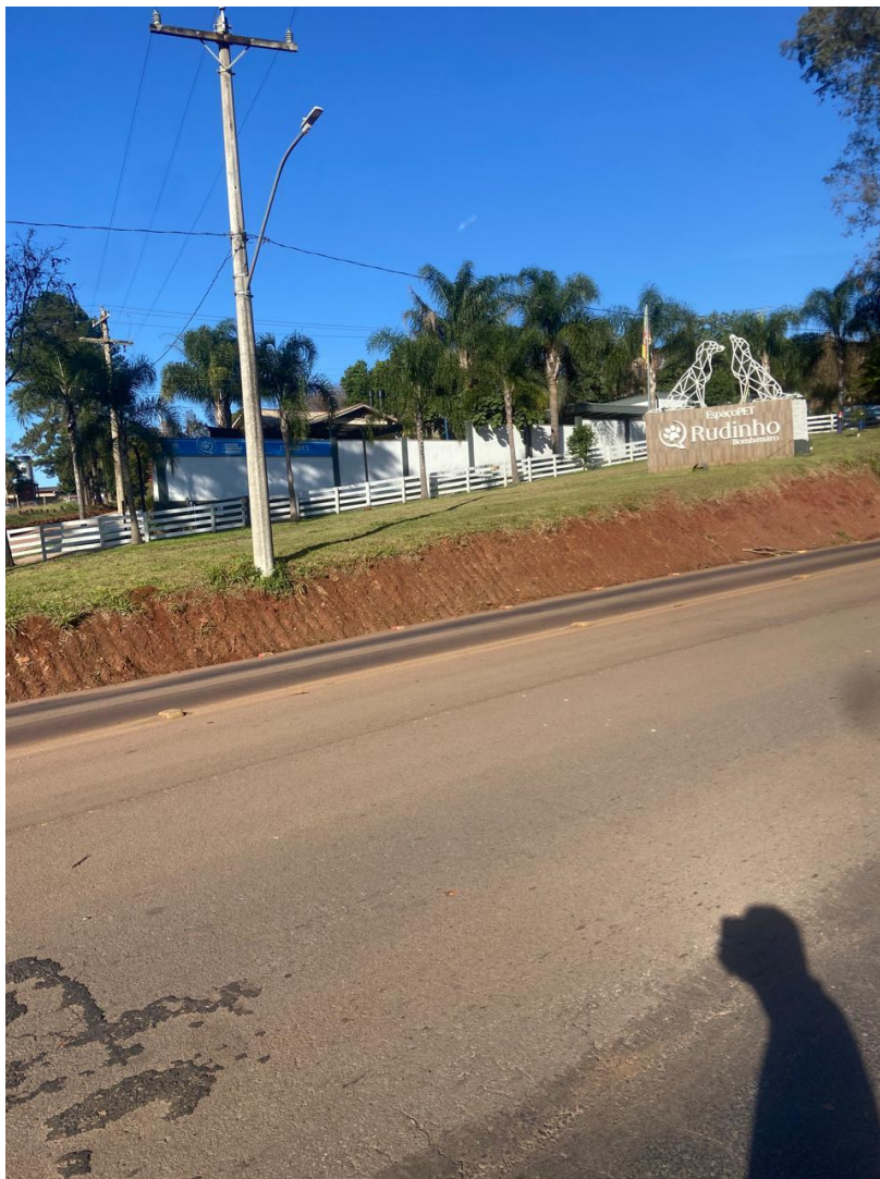
Foto 1 – Fachada norte do Pórtico
