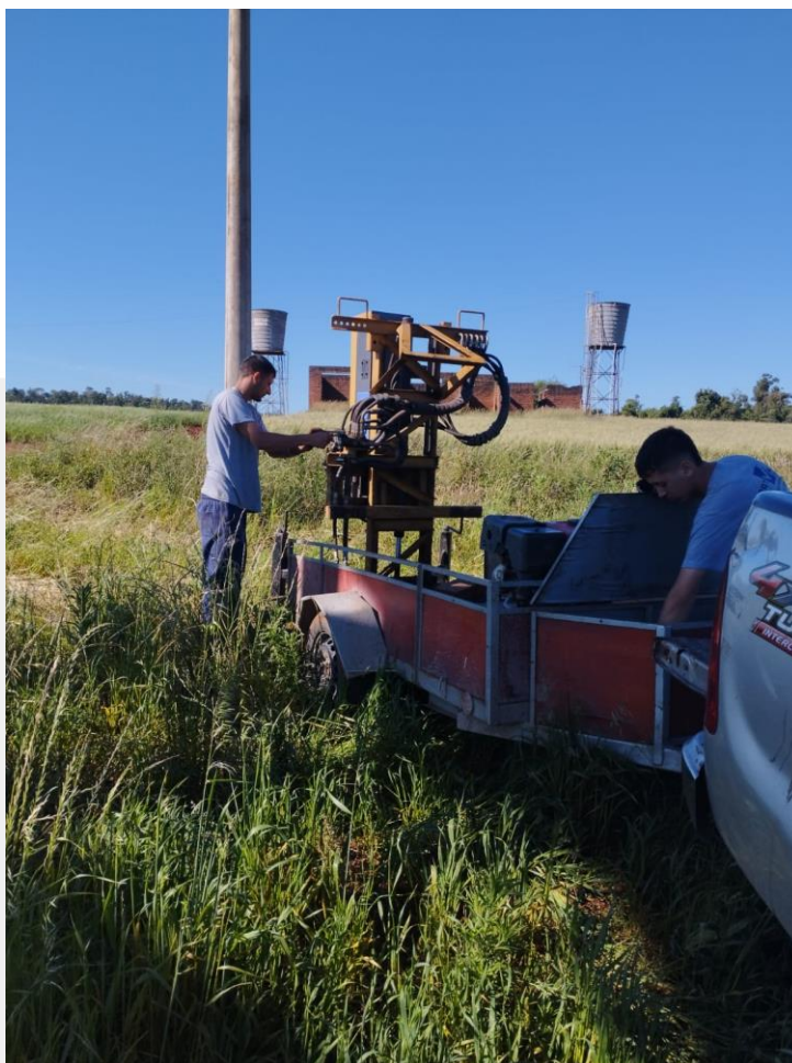
Figura 2: Equipamento sendo utilizado no local no SPT 01
