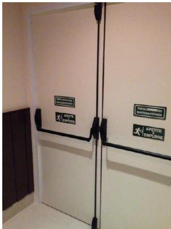
Figura 20: Modelo de barra antipânico com sistema de acionamento via haste vertical metálica.
