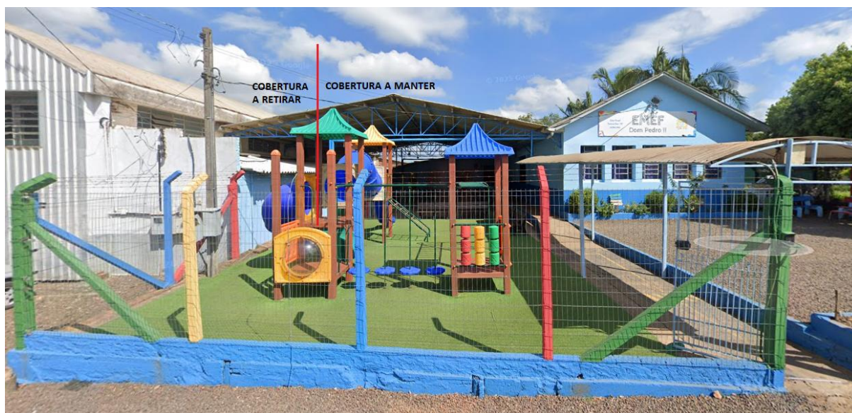
Figura 21: Cobertura existente na EMEF Dom Pedro II.
