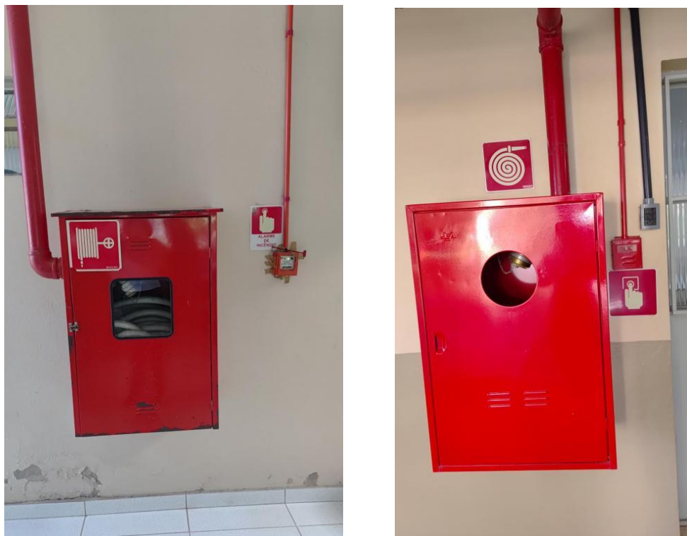
Figura 05: Exemplo de pontos de tomada d'água de hidrantes existentes na EMEI Arco-Íris e EMEF São Judas Tadeu.
