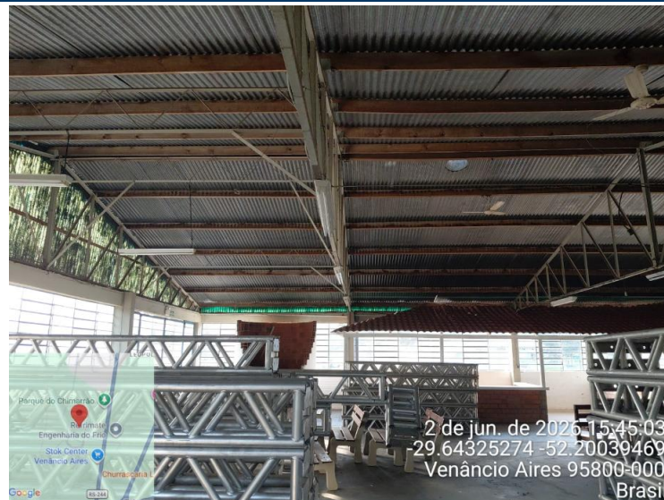
Foto 08: Estrutura de vedação das paredes velhas.
