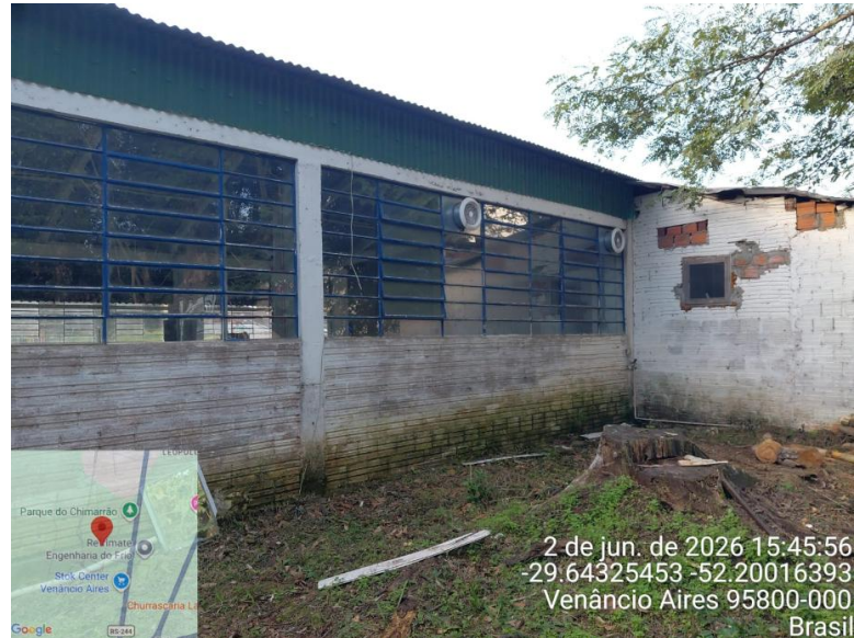
Foto 05: Local onde o pavilhão conecta-se ao anexo.
