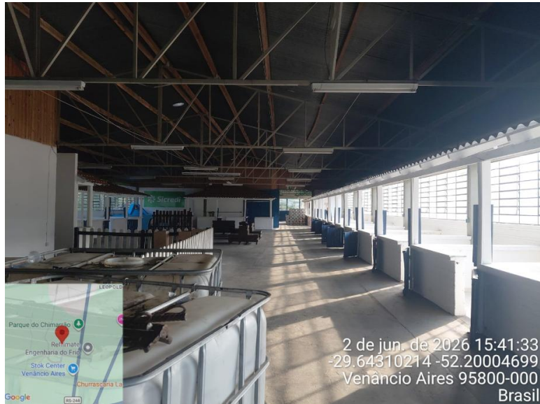
Foto 19: Parte interna vista da frente, quiosques ao fundo serão retirados.
