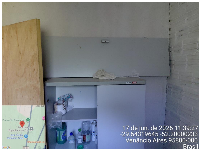
Foto 02: Local do anexo que será remodelado, onde será aberto o vão para acesso aos banheiros.
