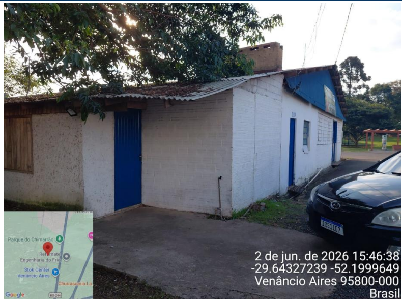
Foto 01: Anexo lateral que será remodelado e parte demolida.
