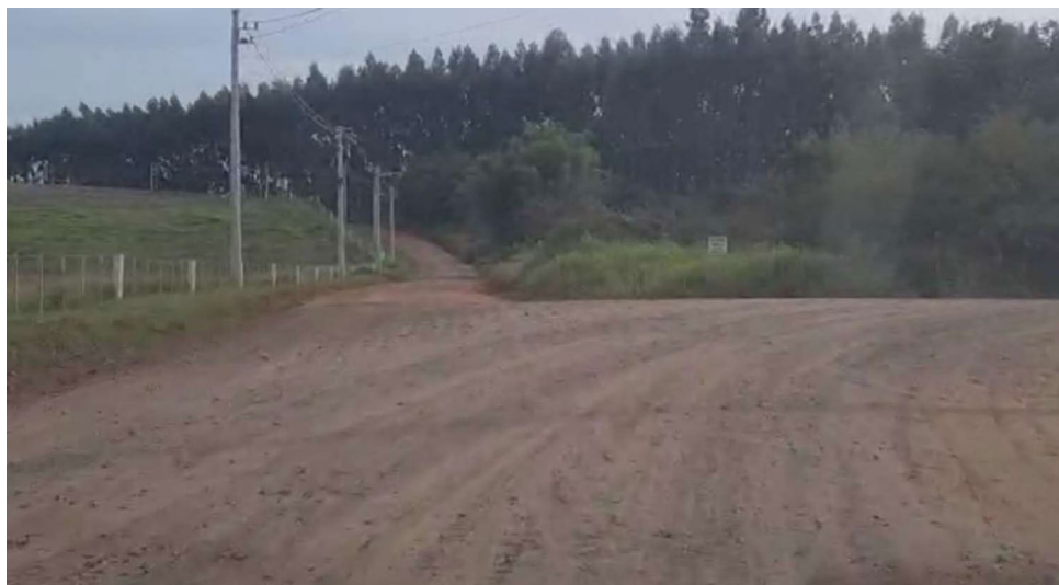
Foto 15: Final do trecho – Estaca 1+418,50
