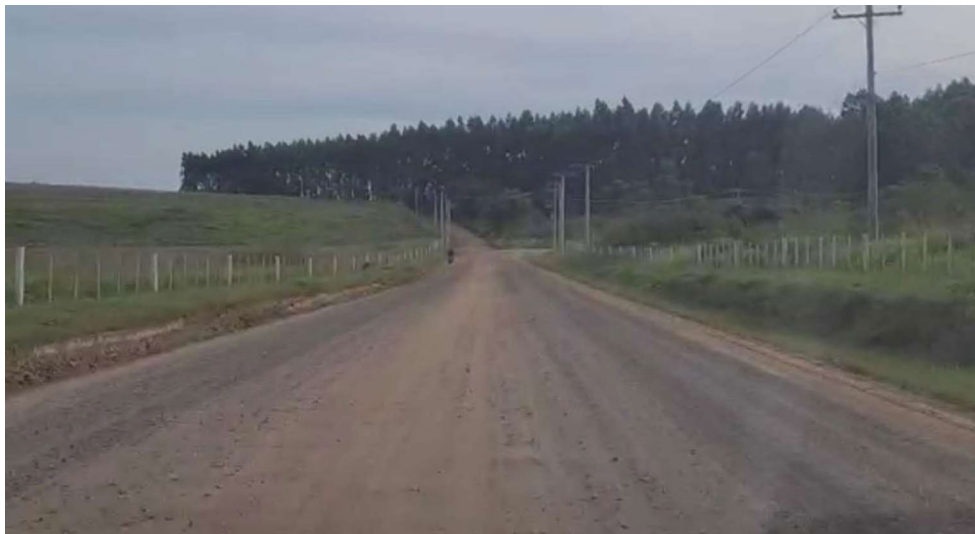
Foto 13: Vista geral do trecho – Estaca 1+200
