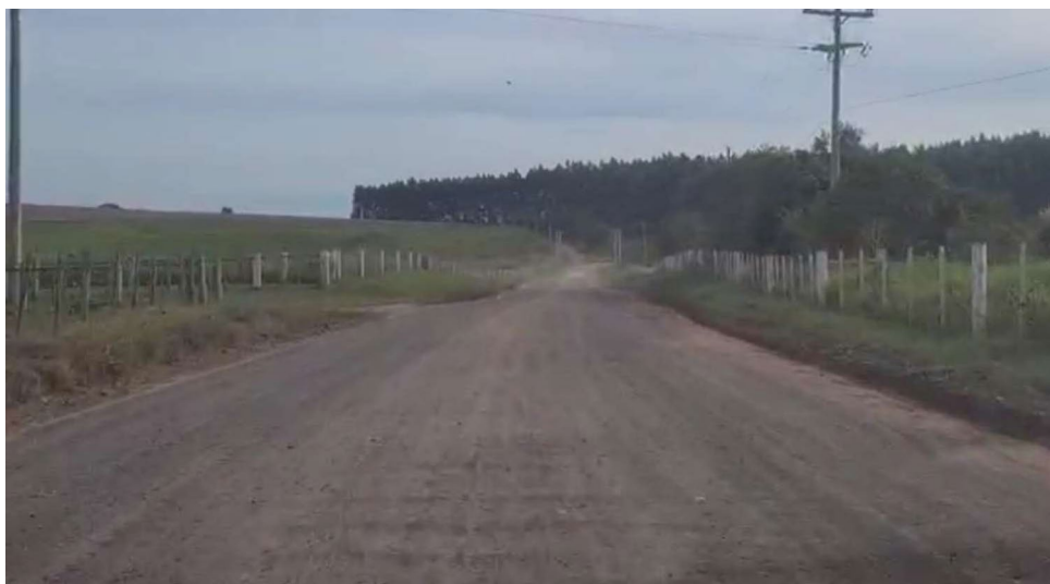
Foto 11: Vista geral do trecho –Estaca 1+000
