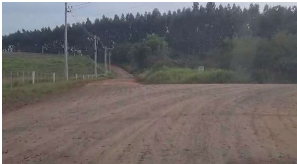
Foto 15: Final do trecho – Estaca 1+418,50
