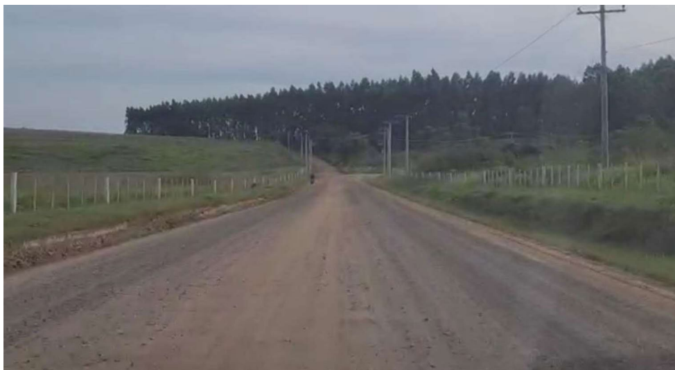
Foto 13: Vista geral do trecho – Estaca 1+200
