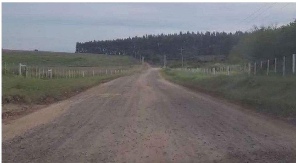
Foto 12: Vista geral do trecho - Estaca 1+100
