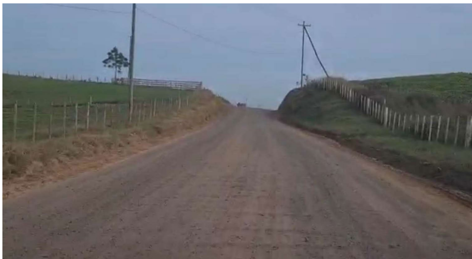
Foto 9: Vista geral do trecho - Estaca 0+800
