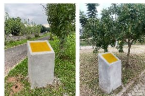
Púlpitos - já construídos
