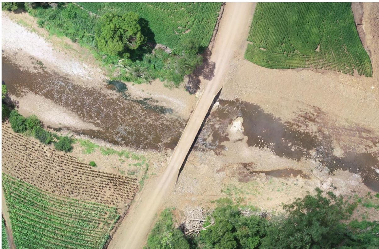
Figura 1 - Localização da ponte
