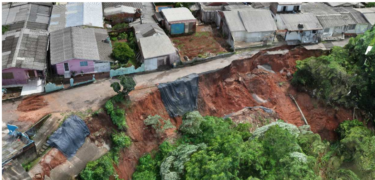
Imagem 02 - Local do colapso do talude
