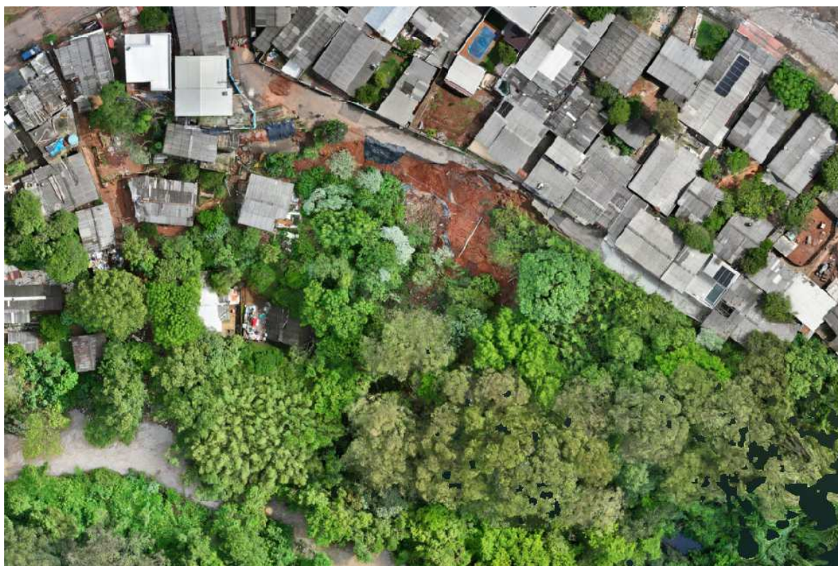
Imagem 03 - Local do colapso do talude
