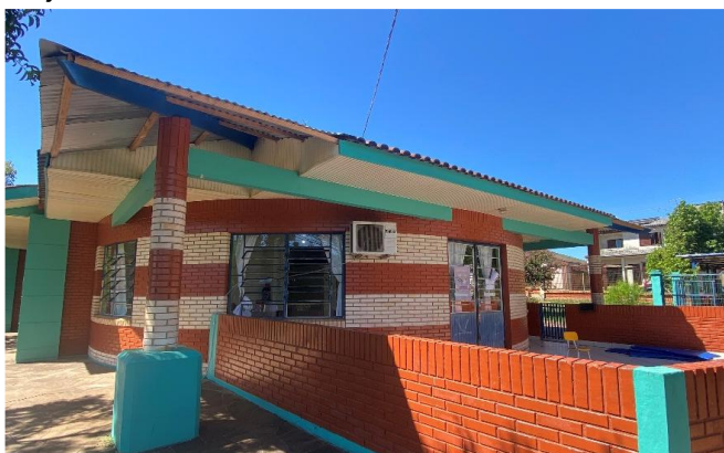
Foto 01: Amostra dos cantos da cobertura a serem trocados, seguindo o alinhamento do beiral ao lado. Fonte: Arquivo Seplan.
