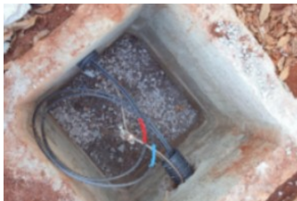
Figura 8: Caixa de Passagem em Alvenaria/Concreto
