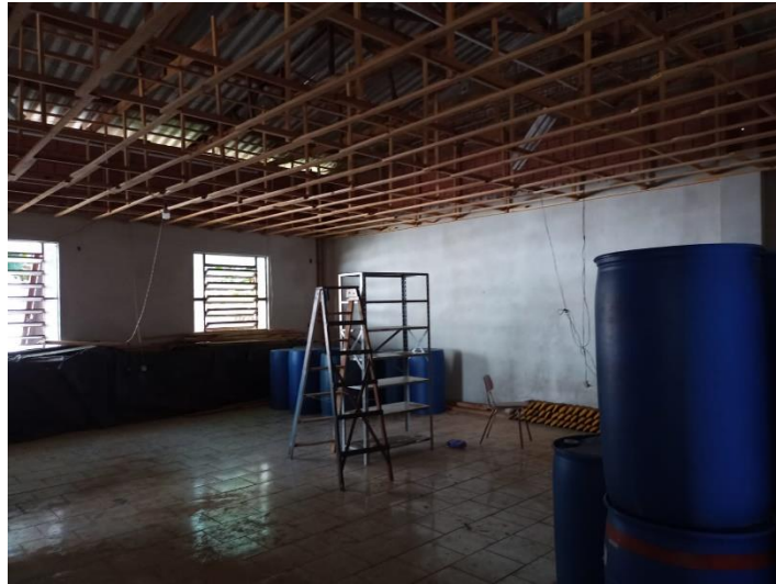
Foto 02: Área Interna do CAS.
