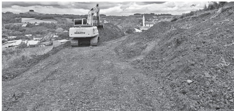
O objetivo da obra é garantir a trafegabilidade e preparar o município para o crescimento ordenado, facilitando o trânsito de veículos e pedestres na região
