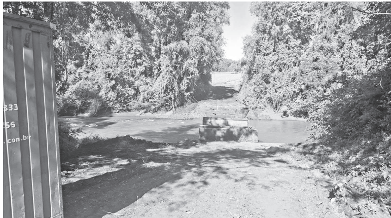
Obra reconstruirá a ligação entre os municípios de Boa Vista do Buricá e São José do Inhacorá
