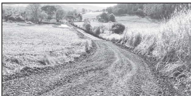
Recuperação de estrada em Esquina Thewes
