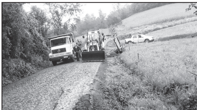
Limpeza de sarjetas de estrada em linha Vênus
