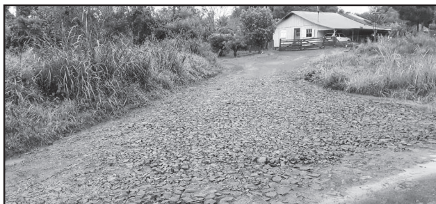
Recuperação de acessos à estrada principal de linha Arnoldo com obra de calçamento em execução
