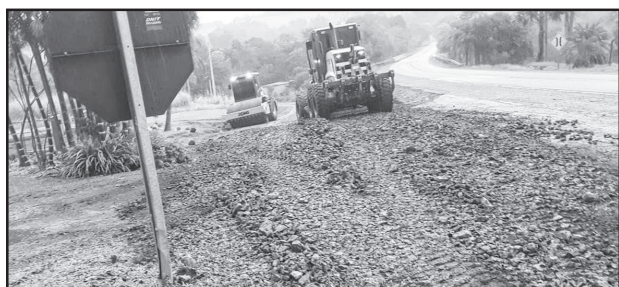
Recuperação de trecho de estrada em linha Três Lajeados
