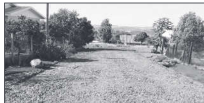
Recuperação de estrada em linha Salto
