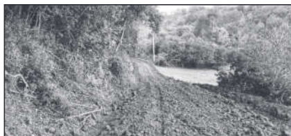
Recuperação de trecho de estrada em linha Rolador Baixo
