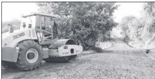
Recuperação de estrada entre Bom Princípio Baixo e linha Revolta
