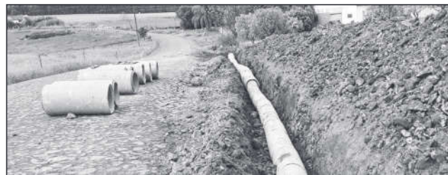
Instalação de tubulação em linha Arnoldo, no acesso ao salão
