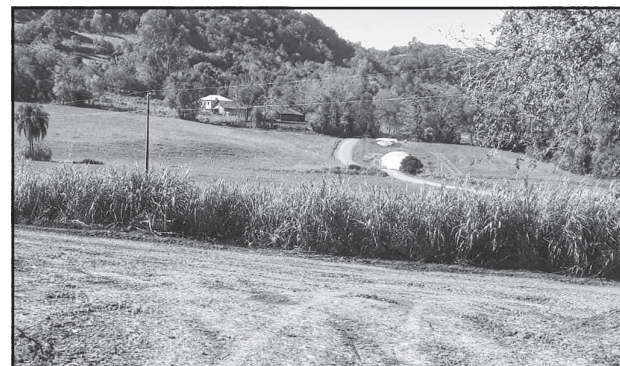
Recuperação de estradas em Linha Doze de Maio
