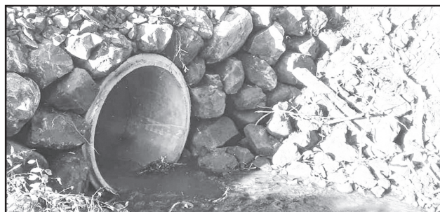
Substituição de ponte de madeira por tubos de concreto em Linha Dona Belinha, no acesso às propriedades das famílias Oliveira e Tewes
