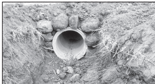
Colocação de tubos de concreto em Linha Doze de Maio e conserto de bueiro em Linha do Rio
