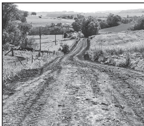
Patrolamento e compactação com rolo vibratório da Rua do Seminário
