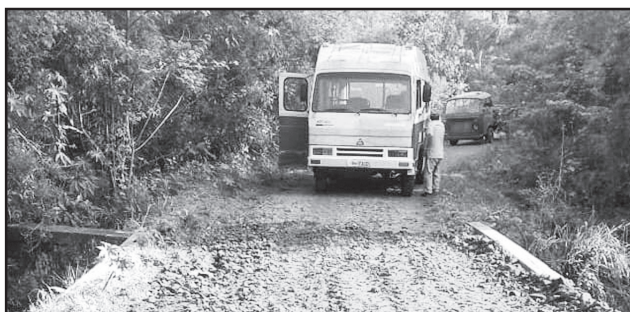
Reparos de ponte em Linha Orion e aplicação de cascalho
