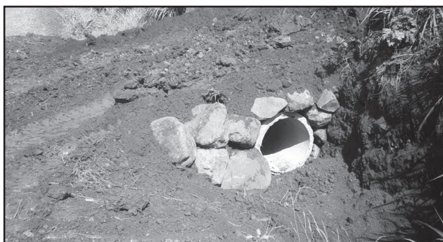
Instalação de bueiro em Linha Divisa
