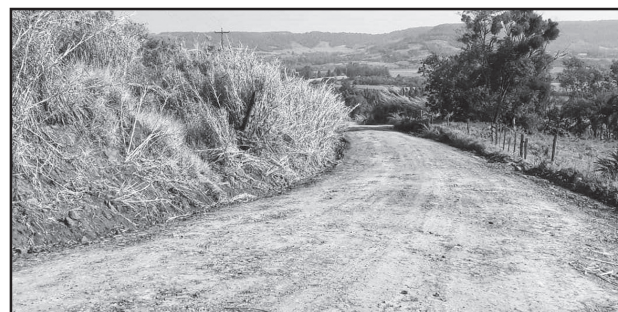
Recuperação de estrada e compactação com rolo vibratório em Linha Doze de Maio
