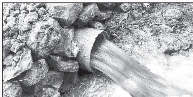
Instalação de bueiro próximo à residência da família Orth, em Vila Sírío
