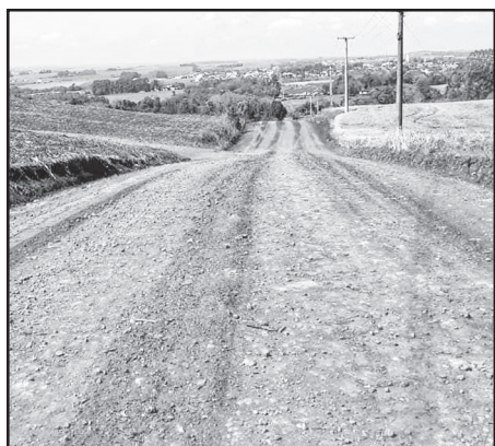
Patrolamento e compactação com rolo vibratório da Rua do Seminário
