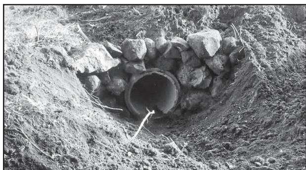
Ampliação de bueiro em Linha Mirim
