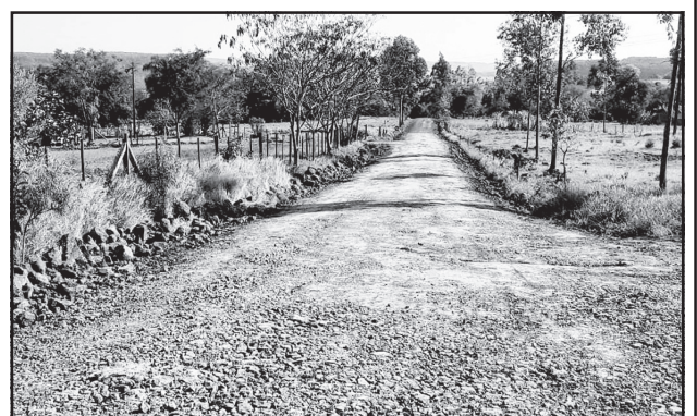
Recuperação de estrada em Linha Doze de Maio
