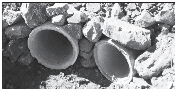
Instalação de bueiro em Linha Dona Belinha
