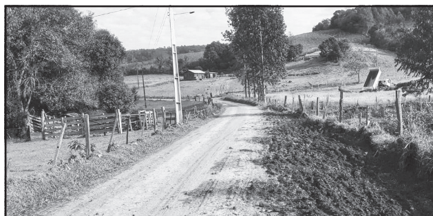
Limpeza de sarjetas em Linha Doze de Maio
