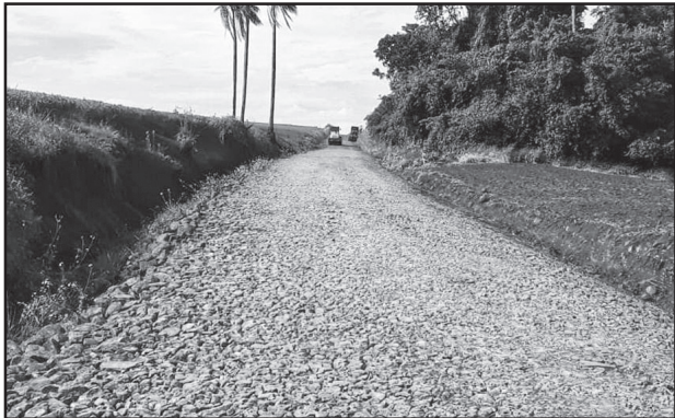
Recuperação de estradas entre as linhas das Antas e Divisa
