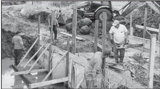
Início de construção de ponte baixa em linha Doze de Maio
