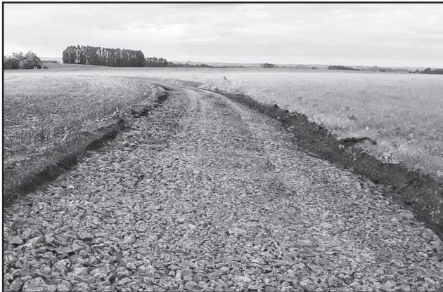
Recuperação de estradas em linha Central
