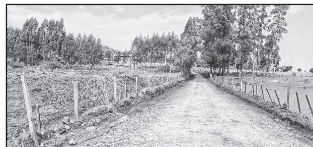
Conclusão de recuperação de estrada em Linha Doze de Maio
