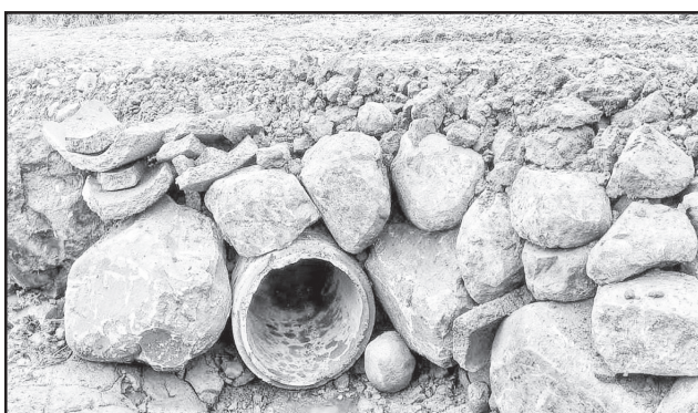
Ampliação de bueiro em Linha Entrada
