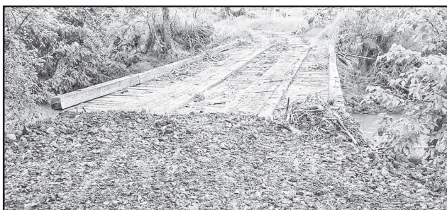
Recuperação de cabeceira de ponte do Rio Boa Vista, em Linha Larga
