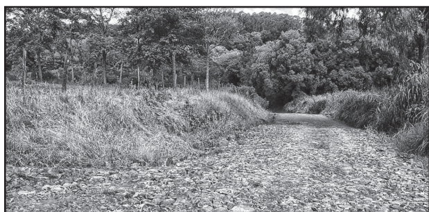
Recuperação de trecho de estrada em Bom Princípio Baixo
