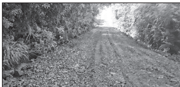
Recuperação de trecho de estrada entre Vila Salto e Linha Divisa
