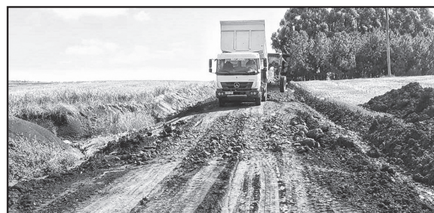
Recuperação de trechos de estrada em Linha Belinha Centro
