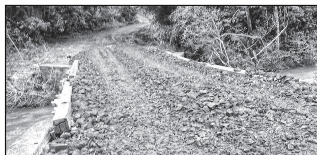
Recuperação de cabeceiras de ponte em L. Orion
