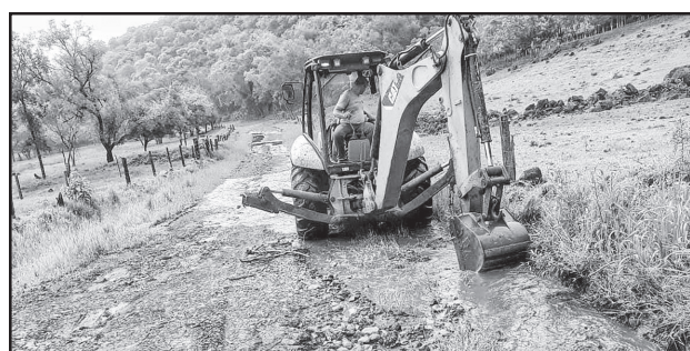
Limpeza de sarjetas e laminação de trecho de estrada em Linha Larga
