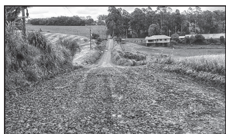
Recuperação da Rua do Seminário
