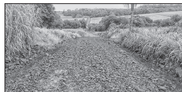
Recuperação de trecho de estrada entre as Linhas das Antas e Taquaruçu
