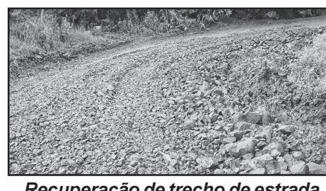
Recuperação de trecho de estrada em Linha Central
