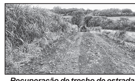
Recuperação de trecho de estrada entre as Linhas Larga e Taquaruçu
