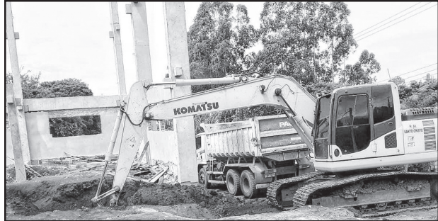
Aterramento de fundações na construção do ginásio de esportes da Escola Paulo Freire
