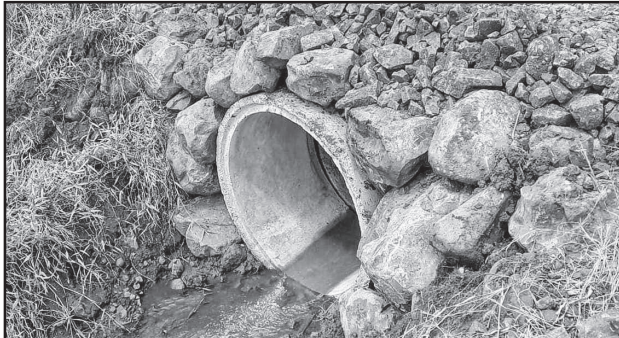
Substituição de ponte de madeira por tubos de concreto em Linha Revolta
