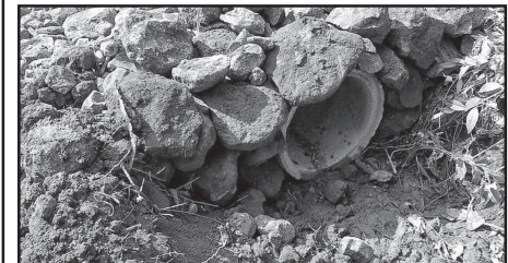
Instalação de bueiro em L. Bananeira
