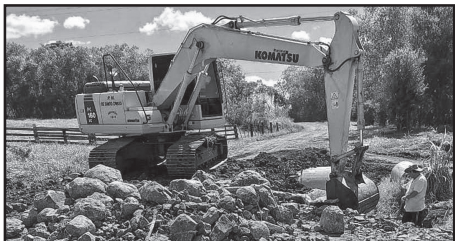
Troca de tubulação em L. Revolta
