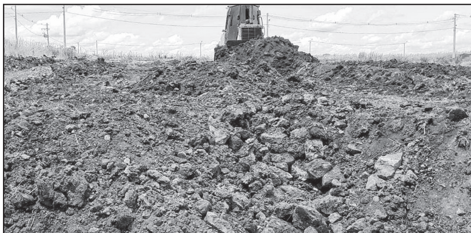
Limpeza de terreno do município na entrada leste da cidade em preparação para instalação de estátua de Cristo
