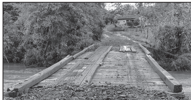
Reparos de ponte em Linha Taquaruçu
