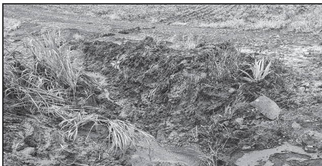
Limpeza de bueiro em Linha Taquaruçu
