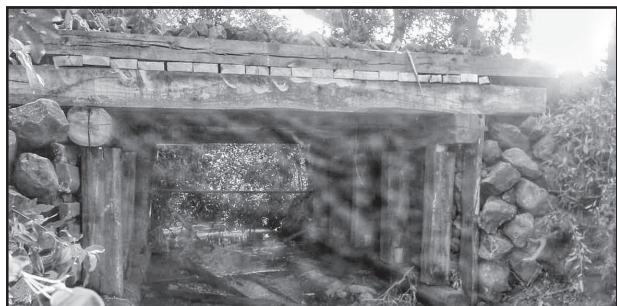
Conclusão de reconstrução de ponte em Linha Alma
