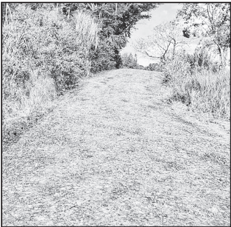
Recuperação de trecho de estrada em Linha Larga
