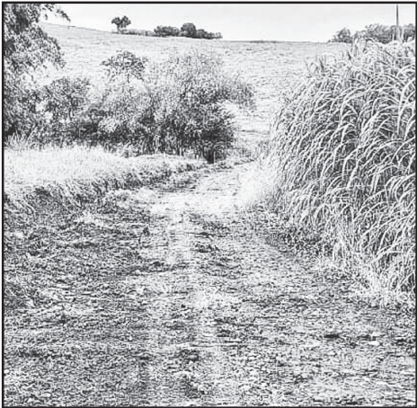
Limpeza de sarjetas em estrada de Linha Larga
