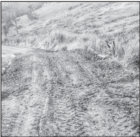
Reparos em pontilhão de madeira (vacaduto), na estrada de L. Bernardo
