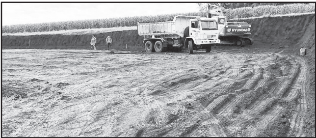
Prestação de serviços pela empresa Lendo Escavações para Valdir Schaefer, em Linha Vênus, pelo programa Invista Mais
