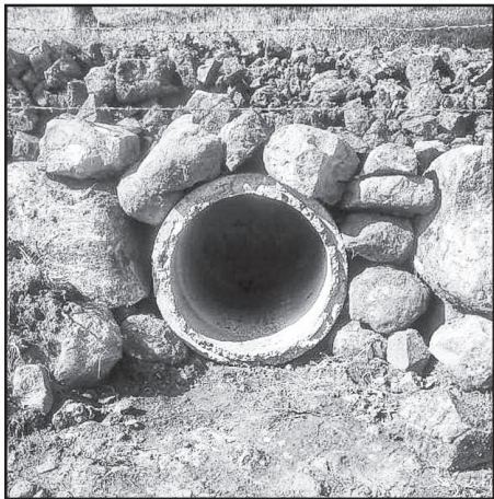
Instalação de bueiro em Linha do Rio
