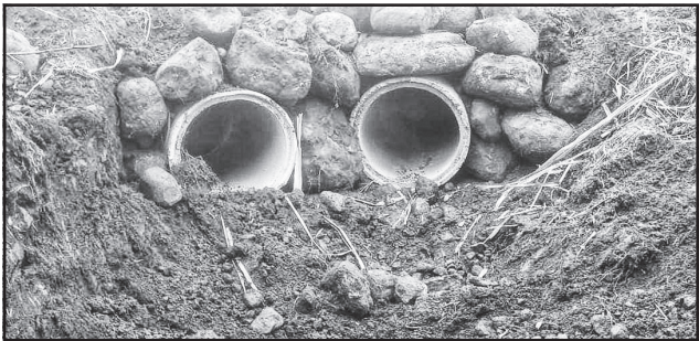
Instalação de bueiros entre as Linhas Larga e Taquaruçu
