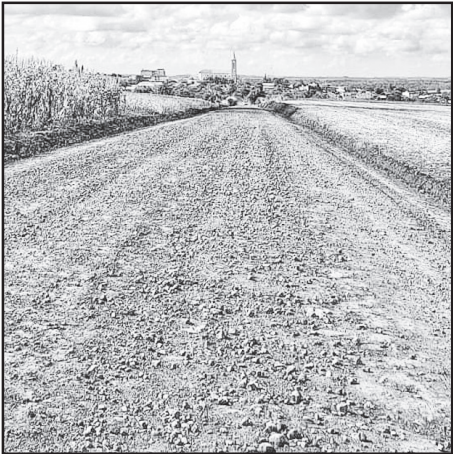
Patrolamento a partir da Rua Benjamin Constant até o asfalto
