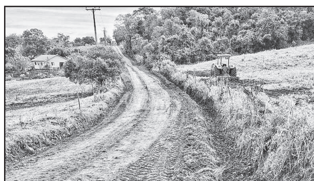
Limpeza de bueiros e sarjetas em estrada de Linha Guaraipo
