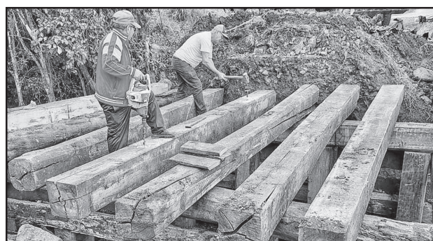
Construção de ponte em Linha Júpiter
