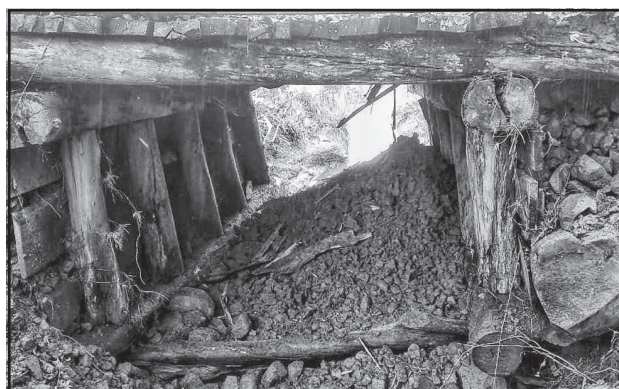
Recuperação de cabeceira de ponte em Linha Herval Novo
