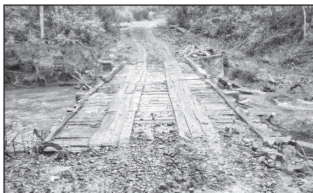
Recuperação de ponte entre Lajeado Vieira e Linha Taquaraçu
