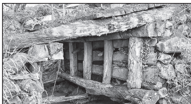
Recuperação de ponte em Linha Herval Novo
