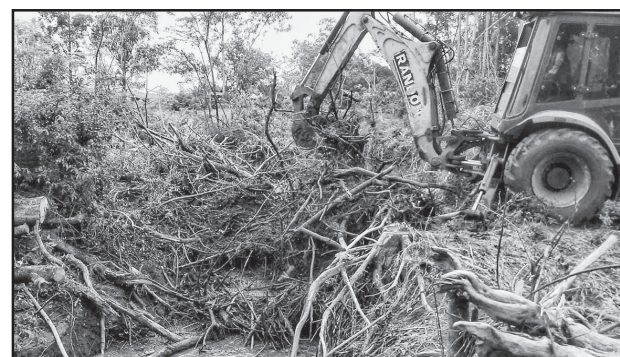
Desobstrução da sanga do Bairro Klering com remoção de resíduos de árvores arrastadas pelas últimas chuvas
