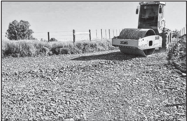
Recuperação de trecho de estrada em Linha Três Lajeados
