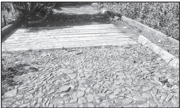
Troca de pranchas de ponte em Bom Princípio Baixo
