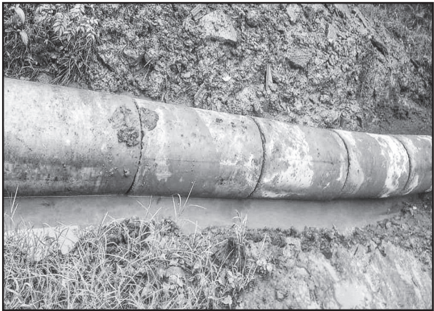
Instalação de bueiro em Linha Bom Fim
