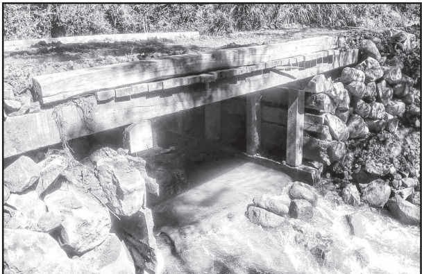
Recuperação de ponte em Linha Castor
