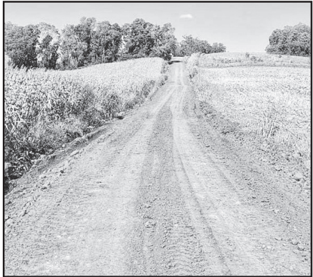
Patrolamento, pela empresa MC Terraplanagem, entre Esquina Andrade e Linha Herval Novo
