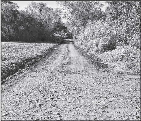
Patrolamento, pela empresa MC Terraplanagem, entre Vila Sírío e Linha Sírío Nordeste
