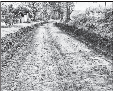
Patrolamento, pela empresa MC Terraplanagem, em Linha Três Lajeados em direção a Vila Salto
