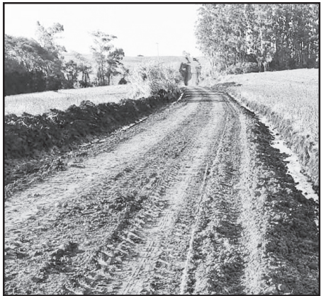
Limpeza de sarjetas em Linha Dona Belinha
