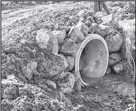
Substituição de ponte de madeira por tubos de concreto na estrada entre as Linhas Dona Belinha e Castor
