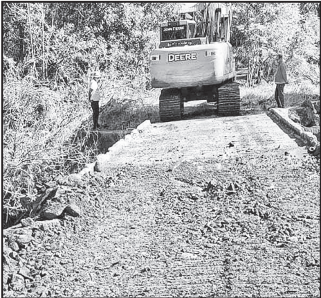
Recuperação de cabeceira de ponte em Lajeado Vieira
