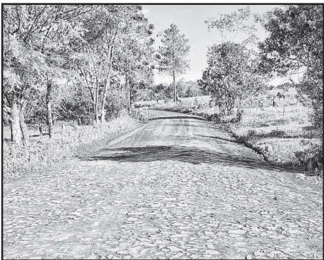
Patrolamento, pela empresa MC Terraplanagem, entre as Linhas Herval Novo e Castor
