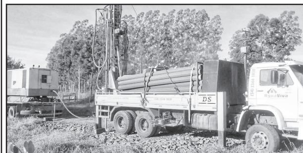
Início da perfuração de poço em Bom Princípio Baixo
