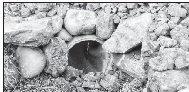
Instalação de bueiro entre as Linhas Belinha Centro e Castor
