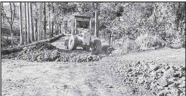
Preparação de leito de estrada para calçamento em Linha Dona Belinha
