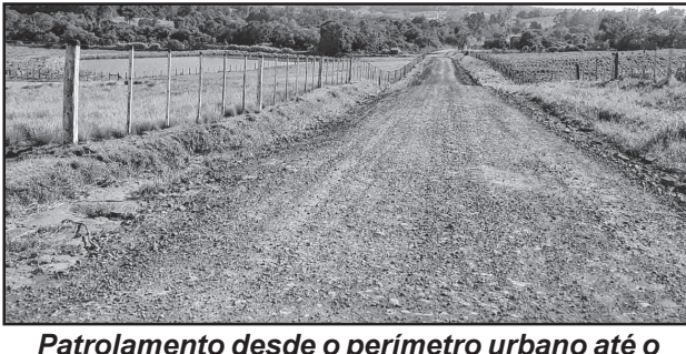
Patrolamento desde o perímetro urbano até o Abatedouro Gallas, em Linha Taquaruçu
