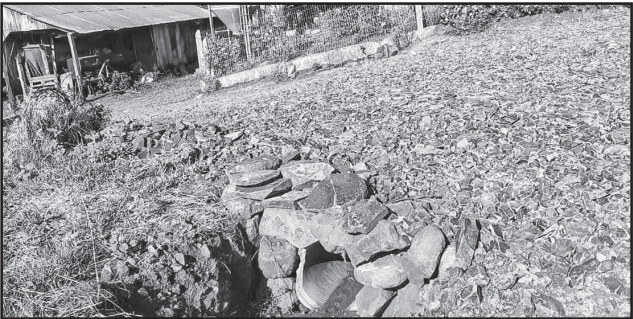
Instalação de bueiro em Linha das Antas
