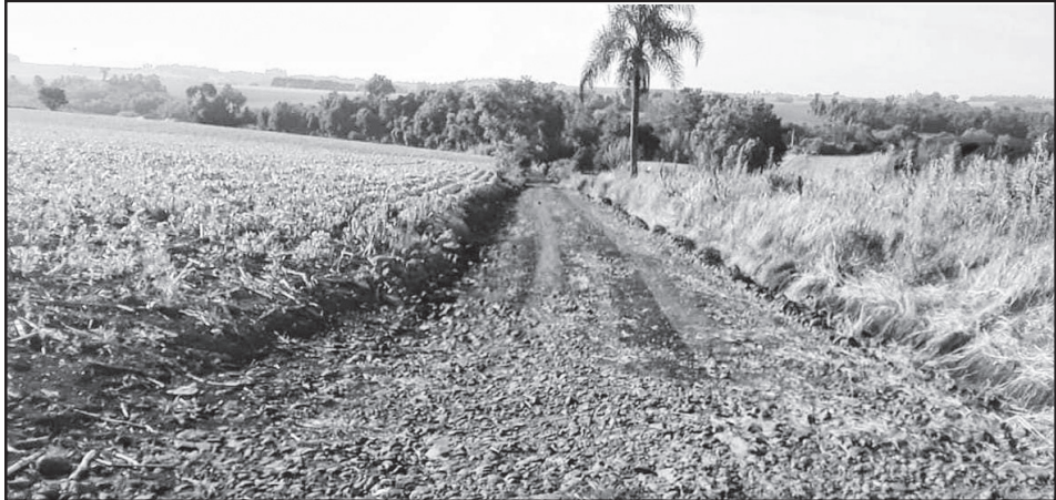
Recuperação de estrada entre as Linhas das Antas e Taquaruçu
