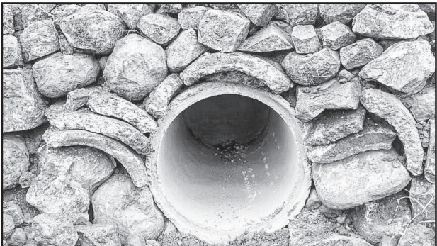
Instalação de tubulação em Linha Belinha Centro
