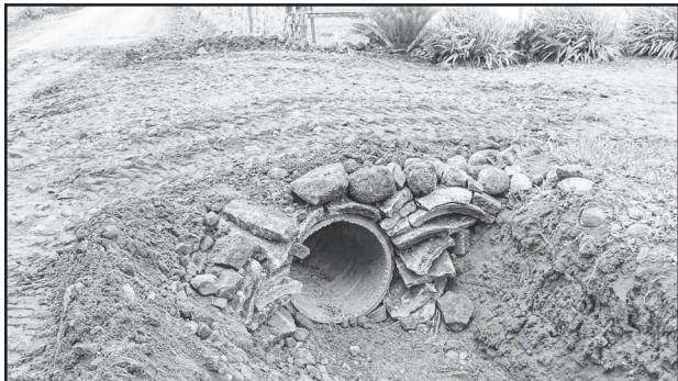
Substituição de tubulação em Linha Belinha Centro
