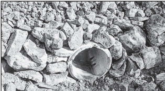
Substituição de tubulação em Linha Taquaruçu
