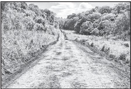
Recuperação de entrada no acesso à propriedade da família Kalsing, em linha Bom Princípio Alto
