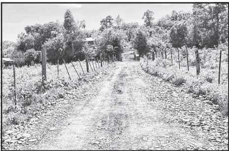
Recuperação de acesso à propriedade da família Magerl, em Linha Taquaruçu
