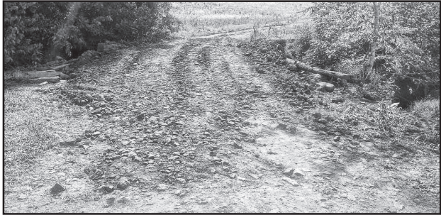
Recuperação de cabeceira de ponte em Esquina Grápia
