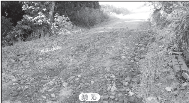
Reforma de ponte em Linha Entrada
