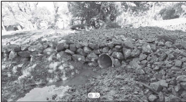
Melhoria do acesso com substituição de pontilhão de madeira por tubos de concreto no acesso à propriedade de Jair Weimann, em L. Dona Belinha
