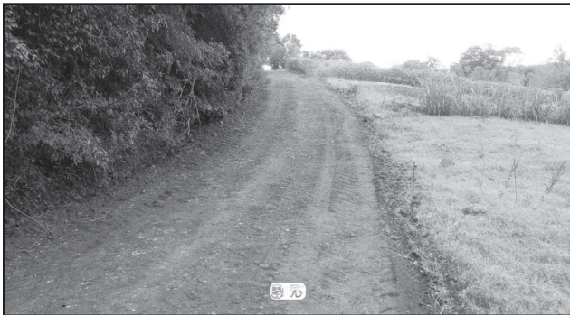
Melhoria do acesso com encascalhamento e patrolamento na propriedade de Leonardo Hemsing, em Linha Dona Belinha
