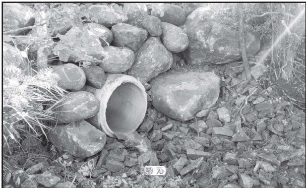
Substituição de tubulação na Linha Divisa
