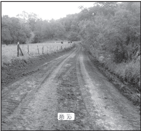
Recuperação de estradas em Lajeado Vieira
