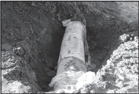
Substituição de tubulação danificada em Linha Vênus
