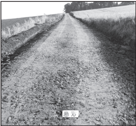
Recuperação de trechos de estradas na Vila Salto
