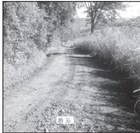
Recuperação de estradas na Vila Laranjeira
