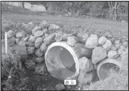
Ampliação de tubulação em Linha Saturno
