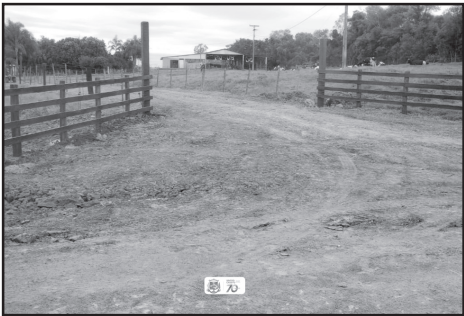
Melhoria do acesso com encascalhamento na propriedade de Alexandre Gallas, em Linha Revolta
