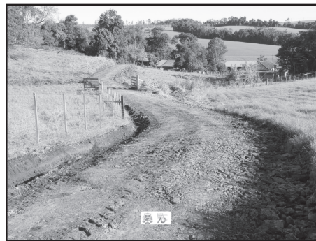
Melhoria do acesso com encascalhamento na propriedade de Laerte Rigo, em Linha Revolta
