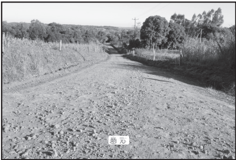
Recuperação de estradas entre a Linha Bom Fim e Vila Laranjeira
