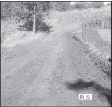
Limpeza de sarjetas em Linha Belinha Centro
