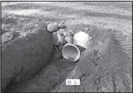
Melhoria do acesso com colocação de tubos na propriedade de Mauro Carvalho, em Linha Saturno
