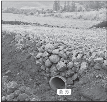
Construída tubulação na Linha Doze de Maio
