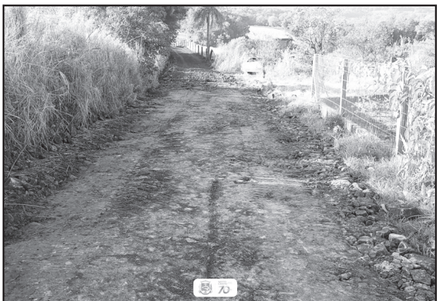
Recuperação de estradas na Linha Alma
