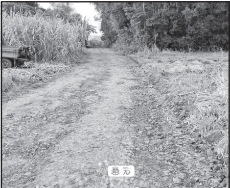
Melhoria do acesso com encascalhamento na propriedade de Arno Pies, na Linha Seca Alta
