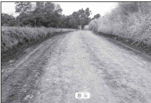
Recuperação de estradas na Linha Doze de Maio
