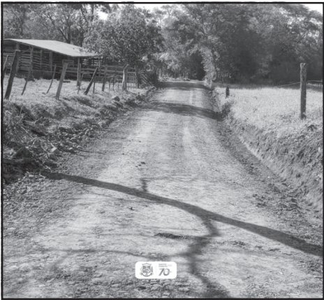
Recuperação de estradas na Linha Seca Alta
