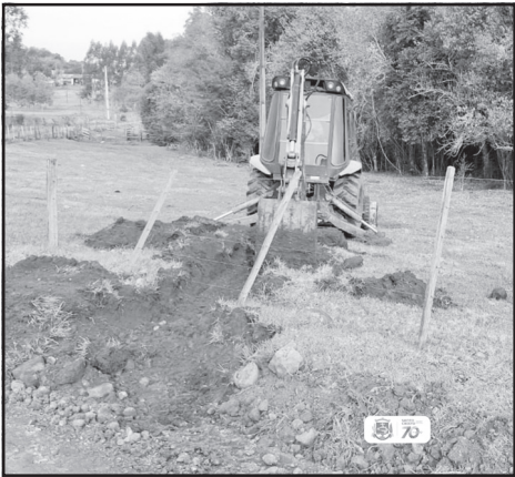
Limpeza de sarjetas na Linha Doze de Maio
