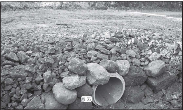
Construção de tubulação na Linha Entrada
