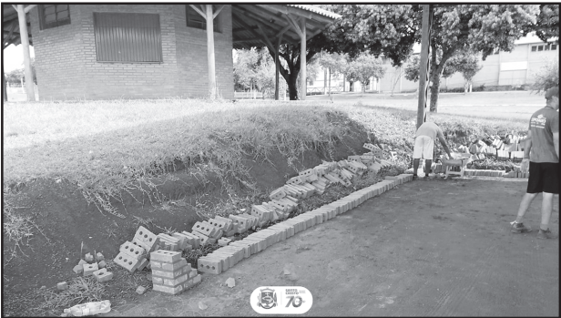
Construção de muro de contenção no parque de eventos
