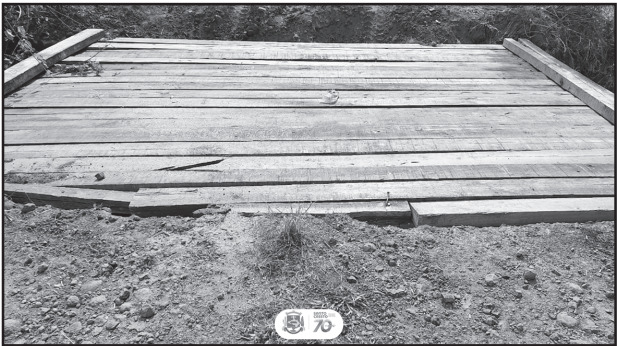
Reforma de ponte em Linha Orion.
