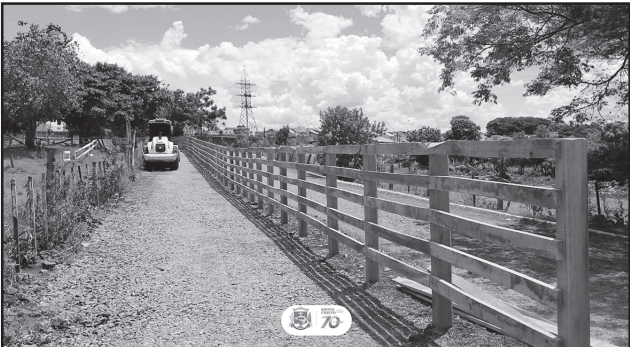
Serviço de compactação na pista de rodeio do parque
