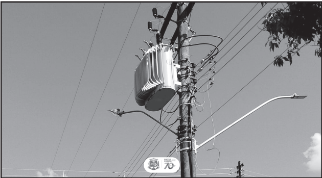
Instalação de mais um transformador no parque de eventos
