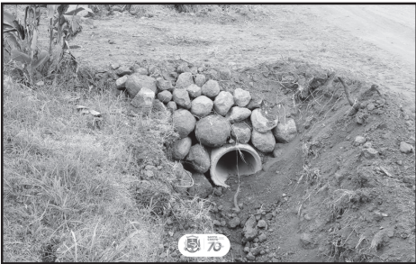
Melhoria do acesso com colocação de tubos para Carlos Schmidt, em Linha Vênus.
