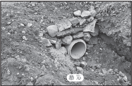
Melhoria do acesso com ampliação de tubulação para Afonso Schaefer, em Linha Vênus.
