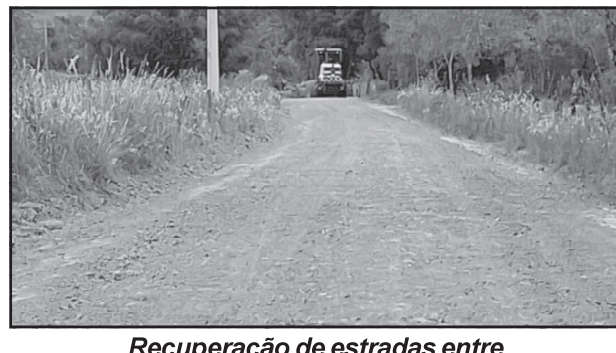
Recuperação de estradas entre Bom Princípio Alto e Bom Fim.
