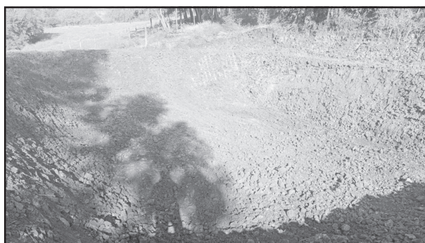
Prestação de serviços de pequeno porte para Adelis Back, na Linha Central.
