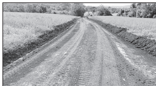
Recuperação de estradas entre Vila Sírío e Sírío Nordeste.
