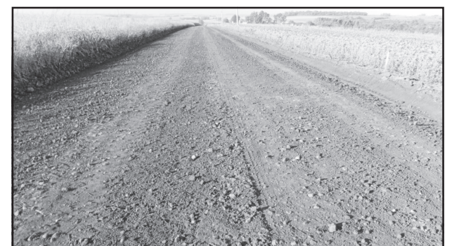
Recuperação de estradas entre Vila Salto e Linha Divisa.
