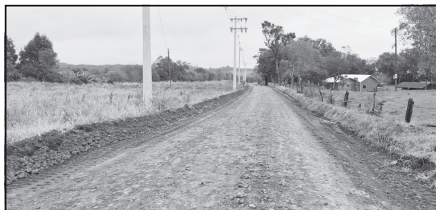
Recuperação de estradas entre Linha Bom Princípio Alto e Bom Fim.
