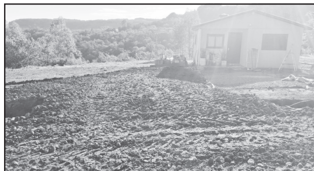
Melhoria do acesso com tubos na propriedade de Eduardo Ullerrich, na Linha Doze de Maio.
