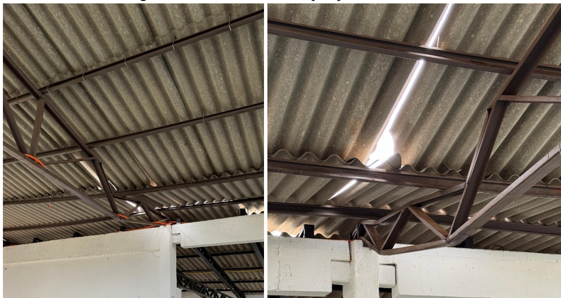
Figura 3: Estrutura metálica após pressão do vento
