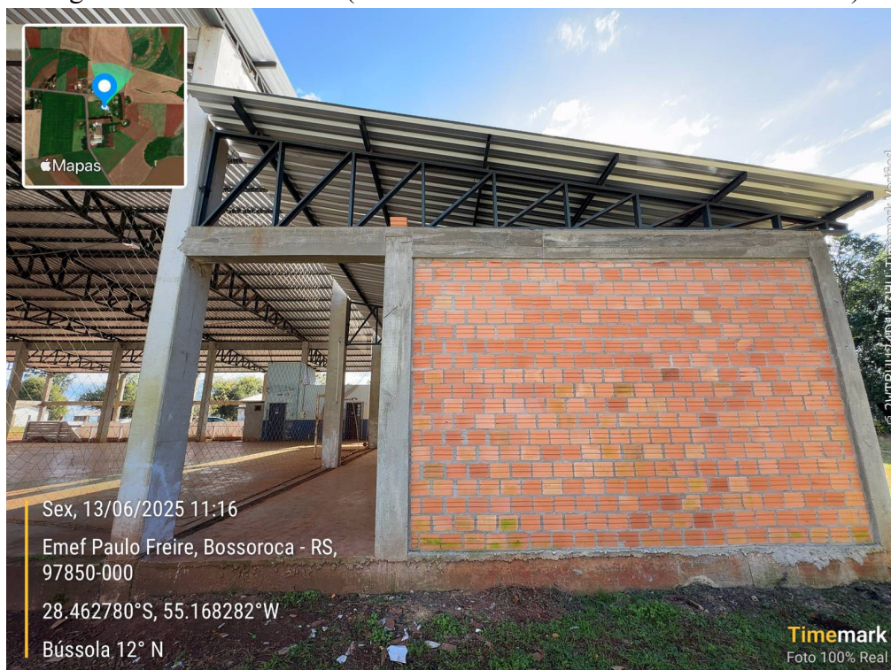
Figura 4: Fachada Lateral (fechamento do oitão com estrutura metálica)
