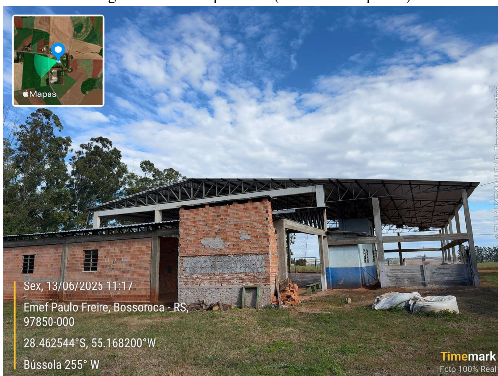
Figura 6: Fachada posterior (local a ser ampliado)
