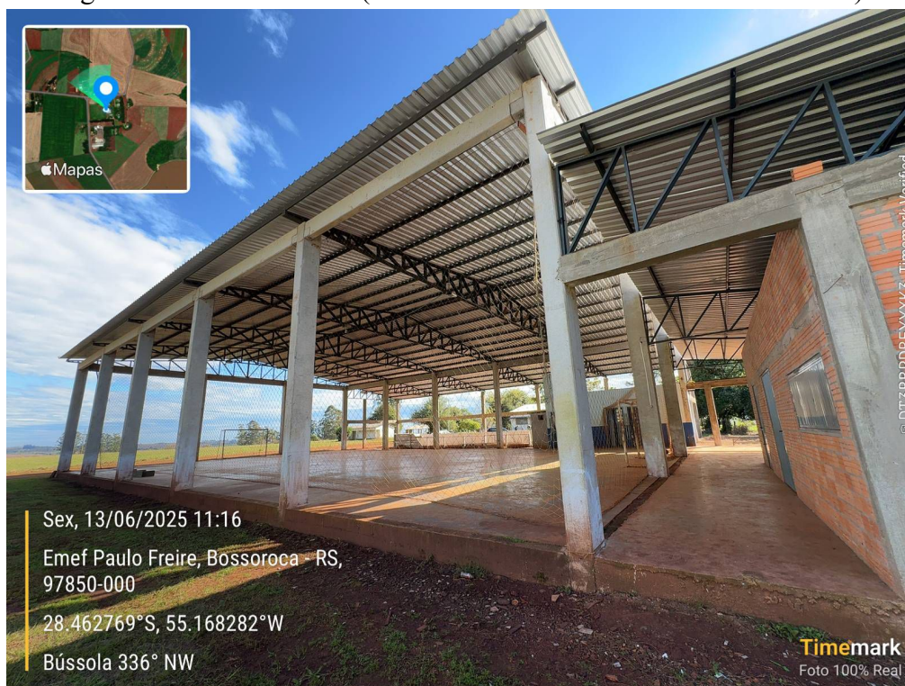
Figura 3: Fachada Lateral (fechamento lateral em alvenaria estrutural)
