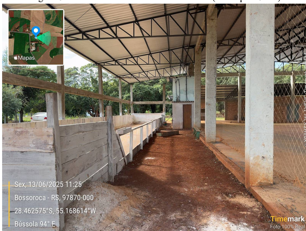
Figura 8: Piso de chão batido a ser concretado (contrapiso 5 cm)
