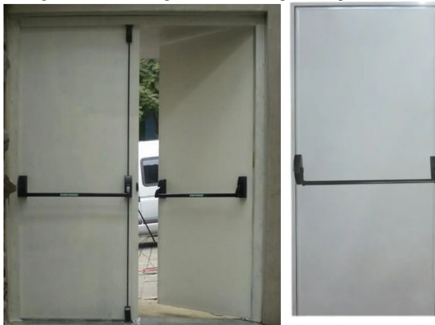
Figura 12: Imagem referência das portas de folha dupla e simples com barras antipânico
