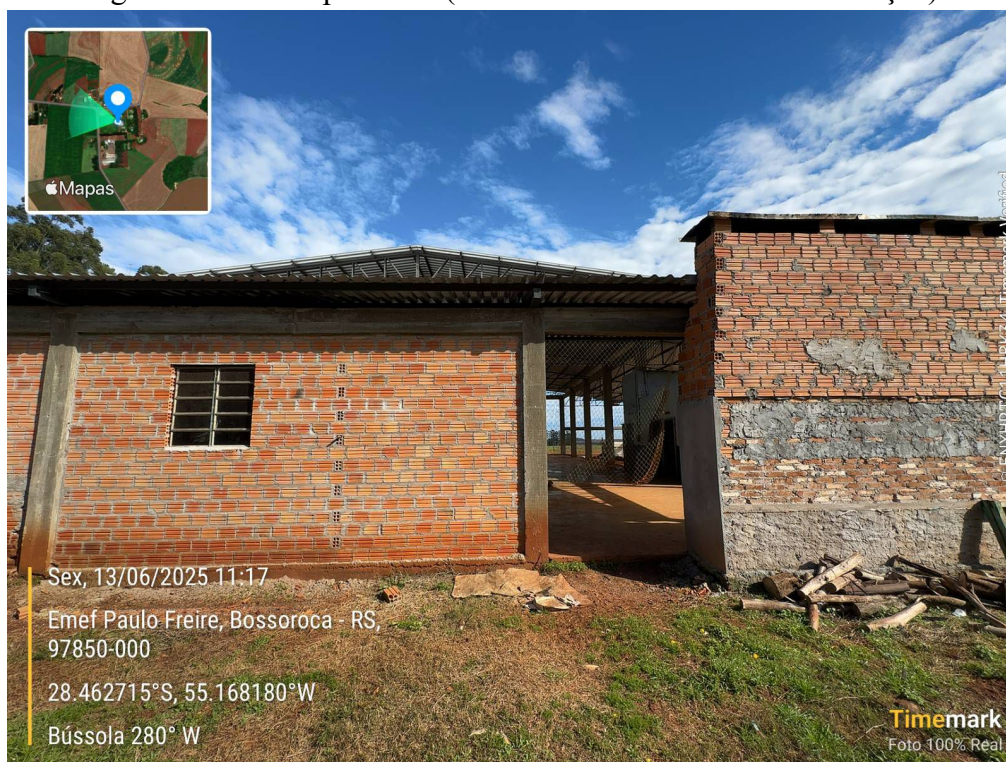
Figura 5: Fachada posterior (fechamento em alvenaria de vedação)
